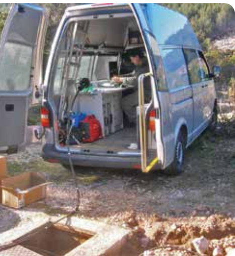
Radovi na spajanju svjetlovodnog kabela
