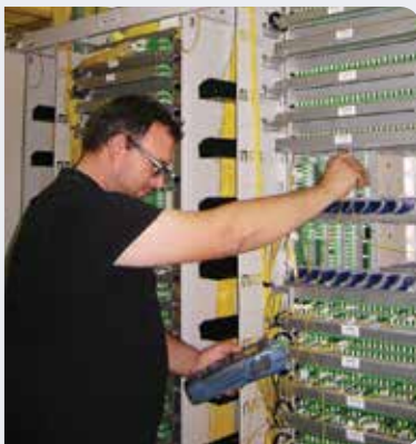
Mario Leonard Rebuš obavlja mjerenje na bakrenom razdjelniku (lijevo), a Josip Antolović na optičkoj mreži (desno)
