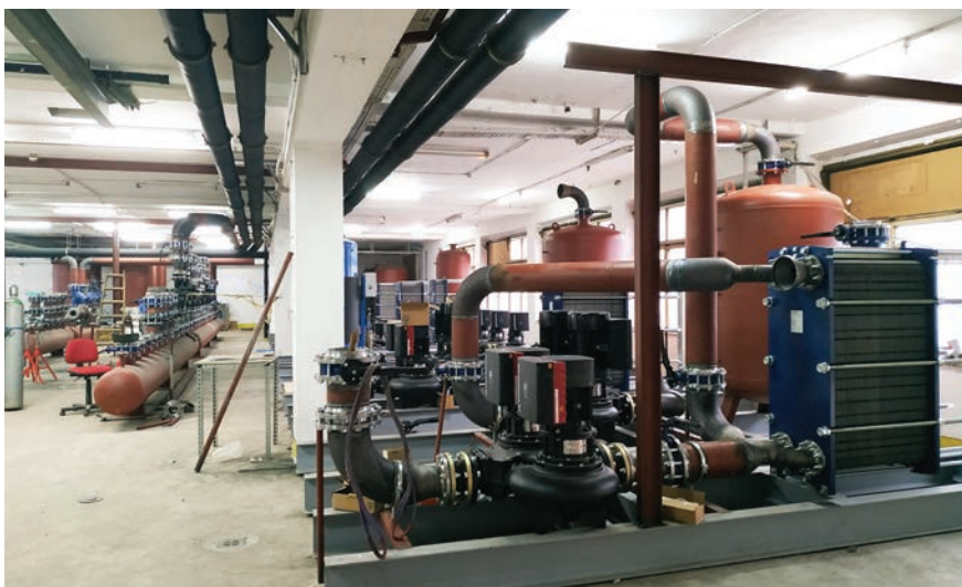
Tijek radova na rekonstrukciji glavne rashladne stanice
