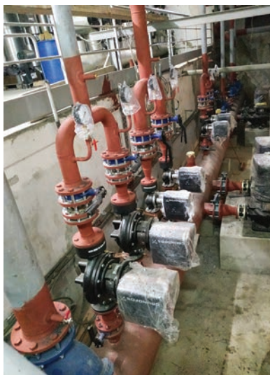
Radovi na glavnoj toplinsko-izmjenjivačkoj stanici
